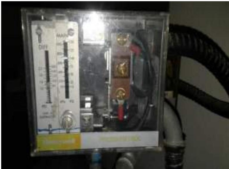
Fig. 12 Presostato del caldero de 15 HP
