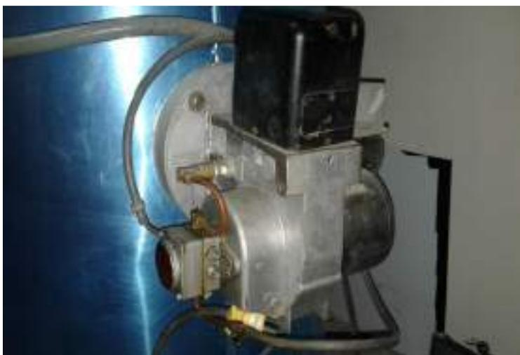
Fig. 8 Quemador del caldero de 15HP
