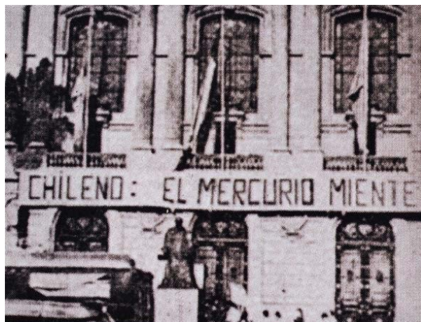
Figura 2: Fachada del edificio del diario El Mercurio
