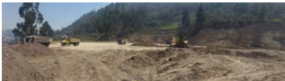
Ejecución de los trabajos para adecuar la plataforma para la Unidad Educativa Siglo XXI.
