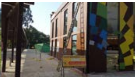
Reparaciones en la Biblioteca
