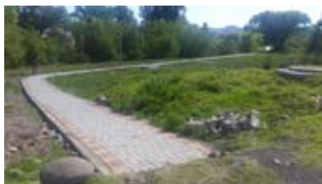
Construcción de caminería
