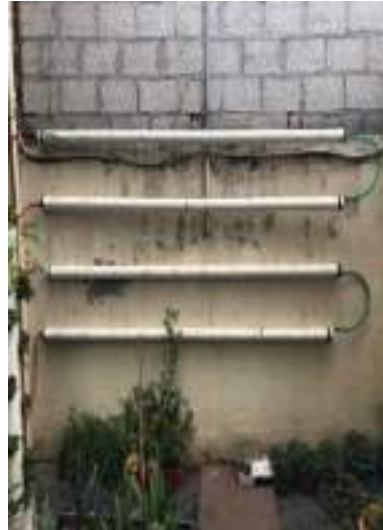
Figura 1. Instalación del sistema Fuente: Autor
