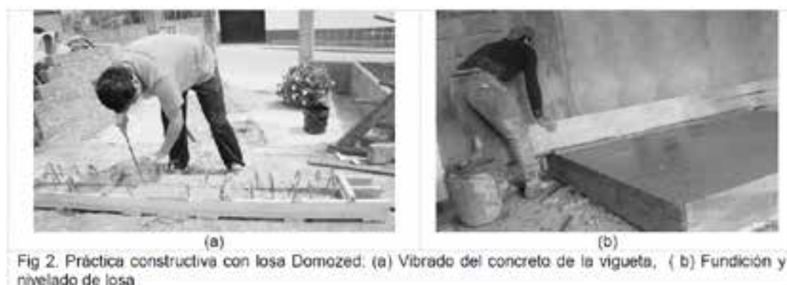
Figura 2. Práctica constructiva con losa Domozed: a) vibrado del concreto de la vigueta, b) Función y nivelado de la losa.
