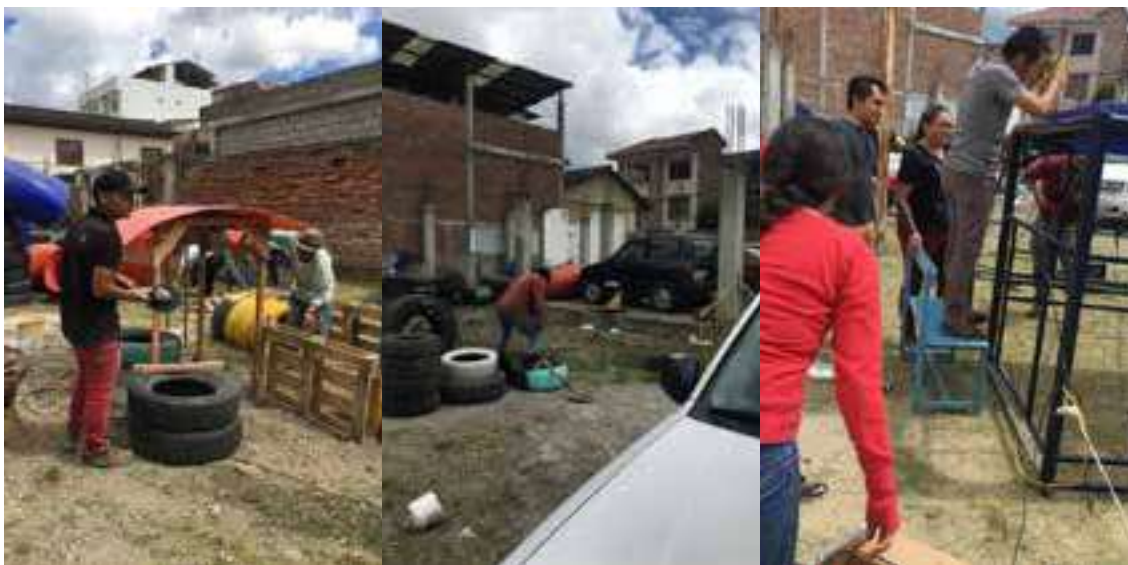
Figura 4. Ejecución del trabajo de construcción de los juegos recreativos.
