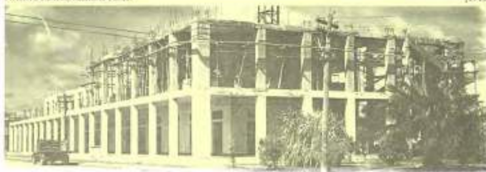
Simbolo urbano de la transformación de Payo Obispo en Chetumal fue el nuevo palacio de gobierno, captado por el fotógrafo Manuel Palma durante la construcción del segundo nivel, el 29 de noviembre de 1944.
