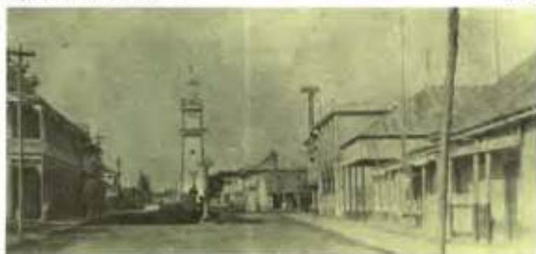
La torre del reloj, único monumento existente en 1918, sirvió de base para trazar el fundo legal.
