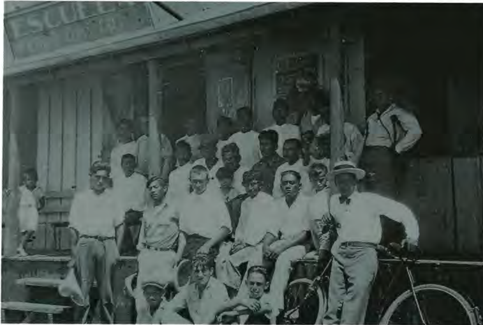
Abrir brechas, tender vías férreas, colocar postes para la comunicación telegráfica y construir modestos edificios públicos, todo como inicial plataforma de la colonización.
