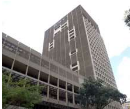
Fig. 2. Edificio sede Banco Central de Venezuela. Caracas.
