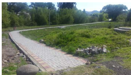
Construcción de caminería
